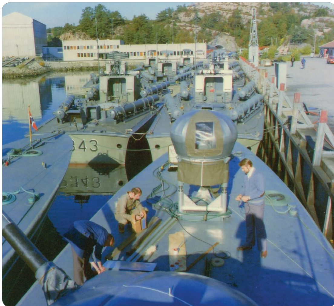
Montering av plattformen på fordekket på KNM Tross ved kai i Haakonsværn. Fra venstre Olav Moen Sandberg, Idar Stafne og Ørnulf Kandola.
