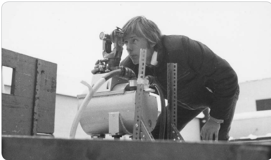
MINAS prototyp under bilprøver. Ragnar Halgunset måler kursnøyaktighet med teodolitt.
